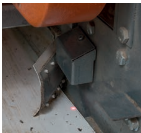
Sensor luminoso para observación del funcionamiento de las cintas
