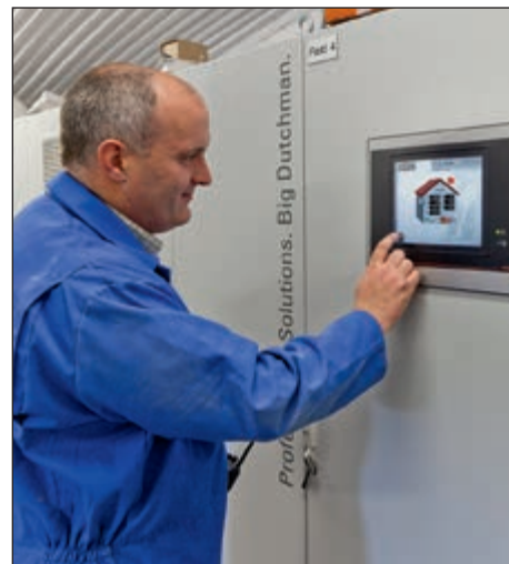
Kiegészítő érintő kijelző a kapcsolószekrényben
